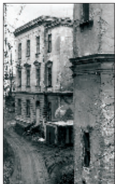
Stav staré budovy
